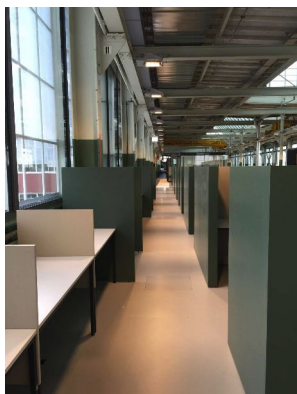
Bibliothek Halle 87, ZHAW Winterthur Decken und Wandverkleidungen FM 500µm farbig lackiert Akustisch aktive Fläche 500m 2
