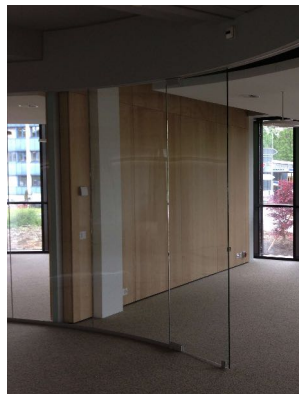
Qiagen Instruments AG Hombrechtikon Wandverkleidung FM 500µm fBirke furniert Akustisch aktive Fläche 400m 2
