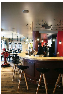
Restaurant Satteltasche Lenzburg Deckenverkleidung FM-Objektpaneelen 500µm CPL 2-farbig NCS lackiert Akustische aktive Fläche 150m 2
