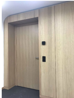
Bahnhof St.Gallen Wand und Deckenverkleidung FM 300µm Eiche furniert Akustisch aktive Fläche 230m 2
