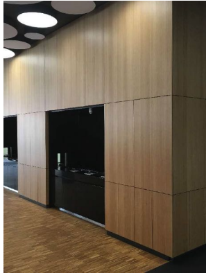
Vector IT Campus Stuttgart Wandverkleidungen Kantine FM 300µm Eiche furniert Akustisch aktive Fläche 140m 2
